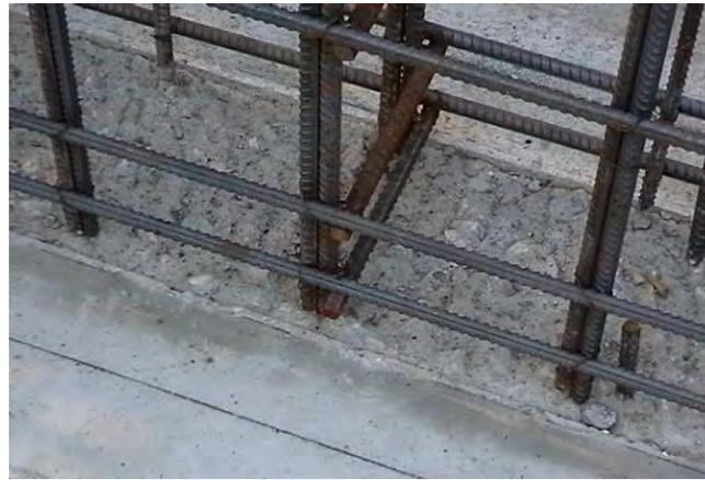
外墙层间接缝处混凝土凿毛处理
