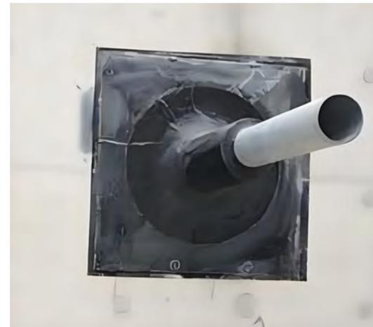
套管端口周边填塞密封胶
