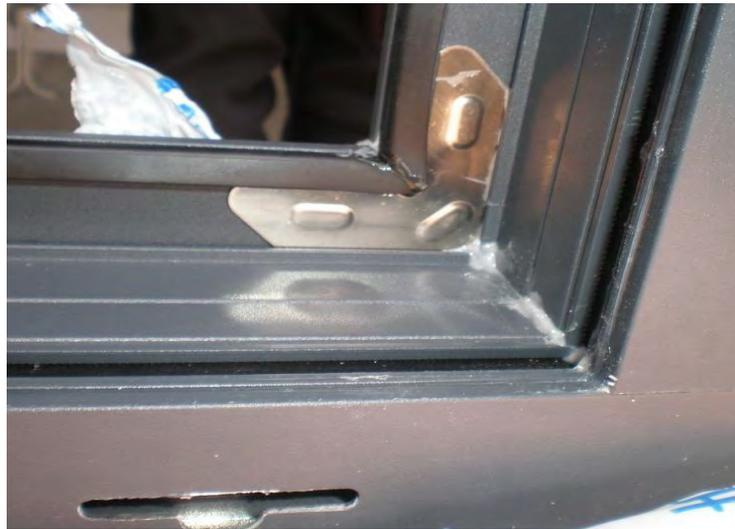
缝隙用硅酮耐候密封胶密封
