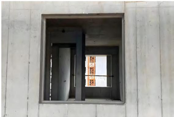
混凝土墙窗洞口周边宜设置挡水企口
