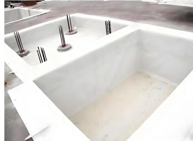
底板预铺反粘防水卷材施工
