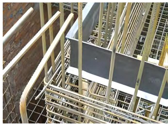
外墙转角处止水钢板安装
