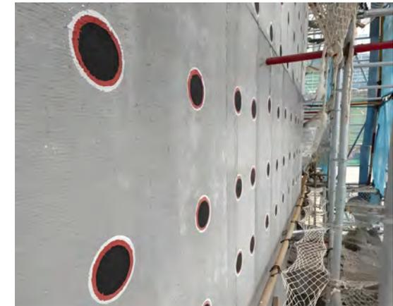
外墙螺栓孔封堵实物图
