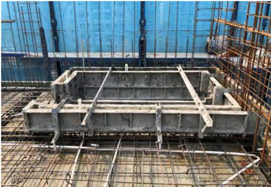
涉水房间混凝土坎台吊模实物图
