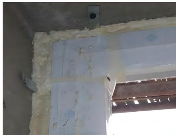
上口及侧口采用发泡聚氨酯灌缝
