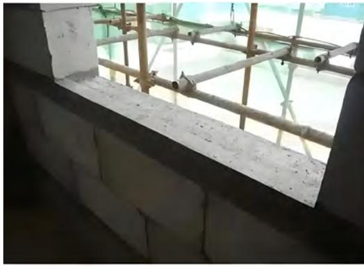
砌体墙窗洞下口设混凝土窗台压顶
