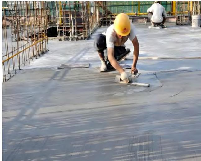
顶板混凝土第二次收面
