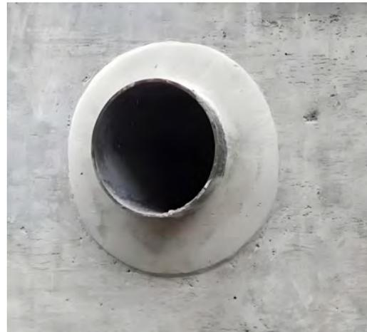
套管与管道之间的空隙密封处理
