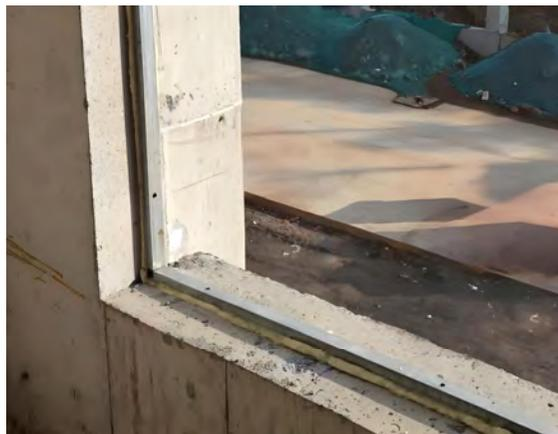
下口间隙采用发泡聚氨酯灌缝
