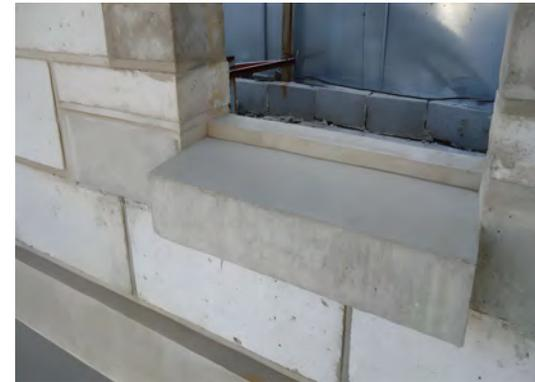
砌体墙窗洞下口设混凝土窗台压顶
