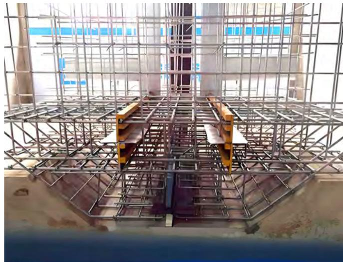
底板后浇带超前止水防水构造样板
