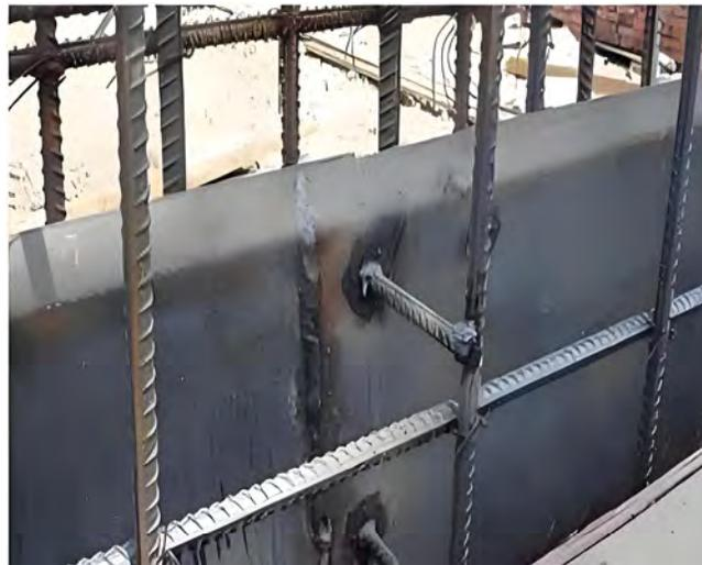
外墙止水钢板短钢筋焊接固定
