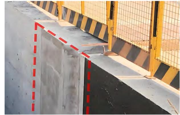
预制混凝土块超前止水完成实物图
