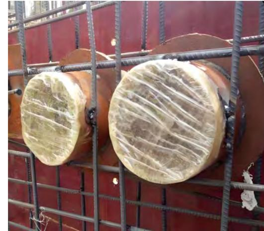
套管式穿墙管安装
