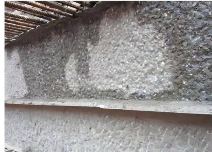
后浇带混凝土两侧凿毛
