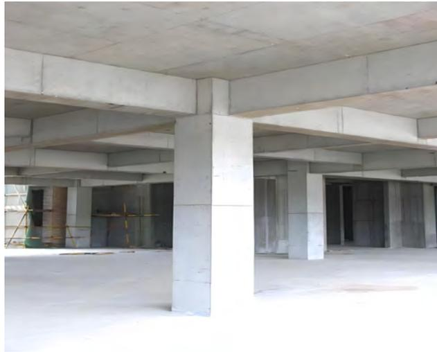
顶板现浇防水混凝土
