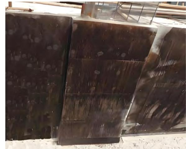
侧墙砌砖超前止水完成实物图
