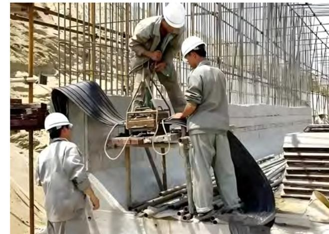
橡胶止水带热压焊接
