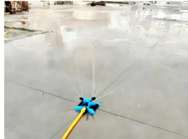
顶板混凝土浇水养护
