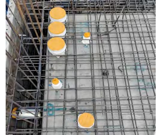
止水节临时封堵保护
