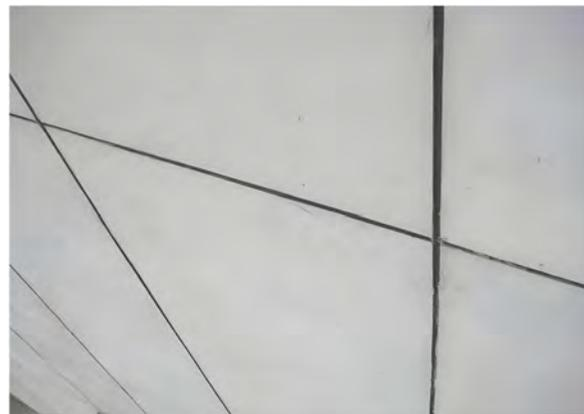
框架填充或砌体结构外墙抹灰抹灰分隔实物图
