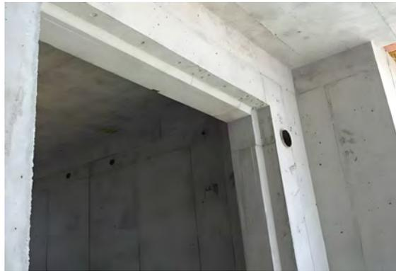
混凝土墙门洞口周边宜设置挡水企口
