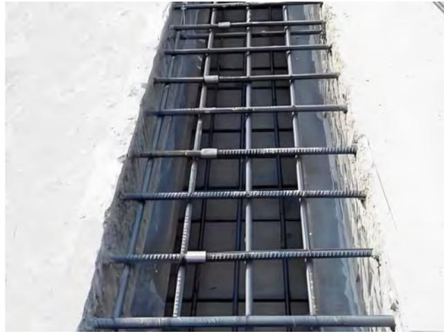
后浇带混凝土两侧凿毛
