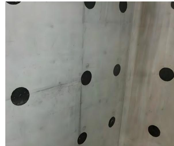
侧墙螺栓孔封堵后涂刷防水涂料
