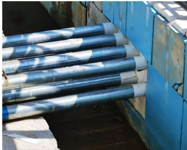
出墙管回填固定
