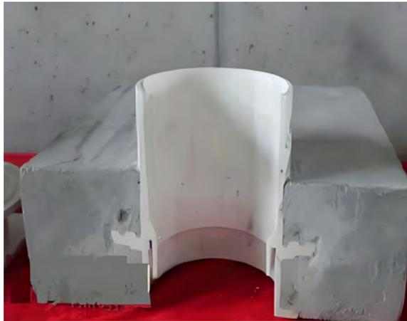
止水节安装构造模型
