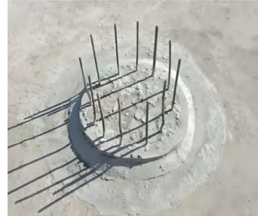
桩侧混凝土抹成圆弧状
