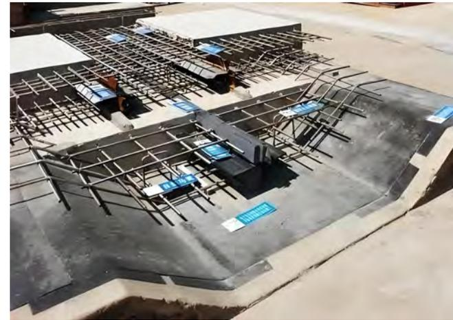
底板后浇带超前止水防水构造样板
