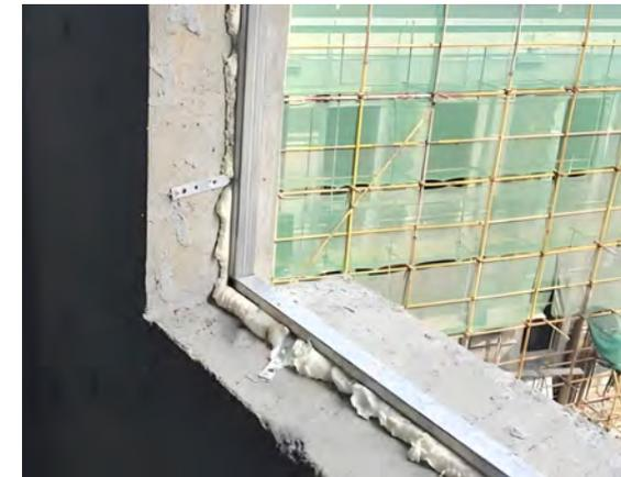
下口间隙采用发泡聚氨酯灌缝
